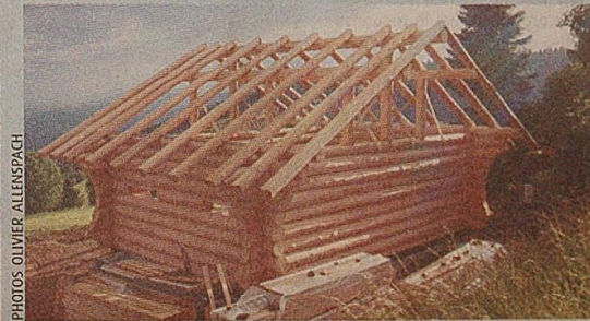
En moins de douze heures, les parois et la charpente de la future villa ont été installées. Restent à attaquer les finitions: toiture, isolation et surtout découper portes et fenêtres. Ensuite, les aménagements intérieurs pourront débiter.
