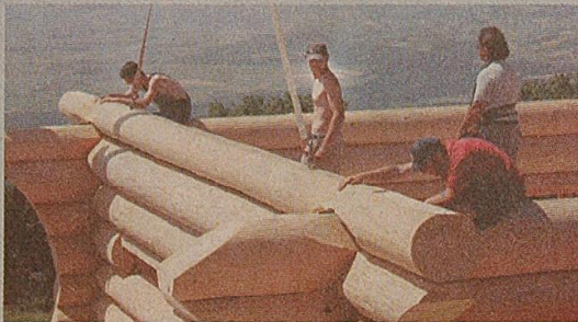
En moins de douze heures, les parois et la charpente de la future villa ont été installées. Restent à attaquer les finitions: toiture, isolation et surtout découper portes et fenêtres. Ensuite, les aménagements intérieurs pourront débiter.
