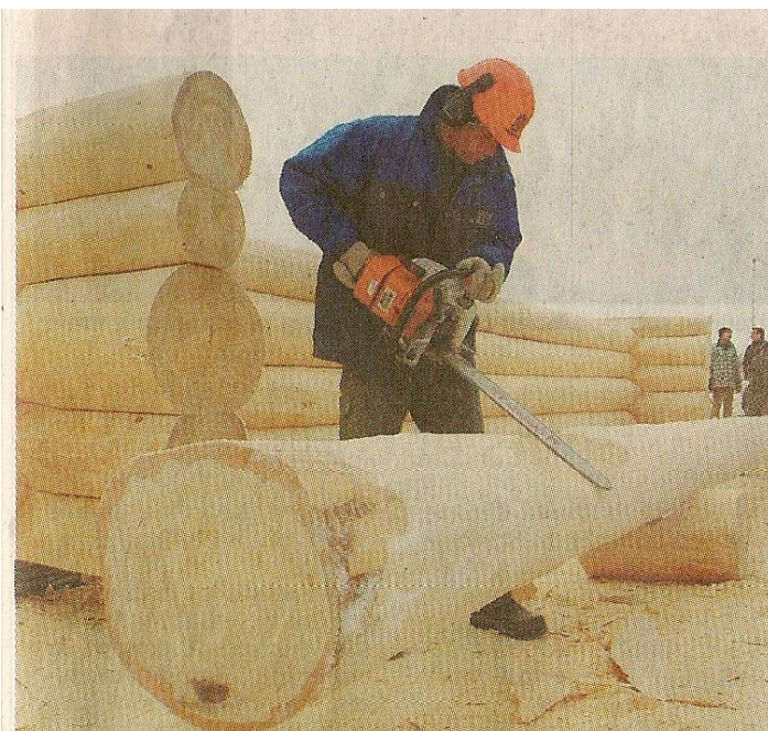
La technique de construction de ce chalet en rondins est celle des pionniers du Nord qui n'avaient que leur hache et la forêt à disposition.
